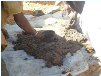
5. Une matière en plastique renforcée par le mélange précédent est utilisée pour couvrir le toit et diminuer l'infiltration.
