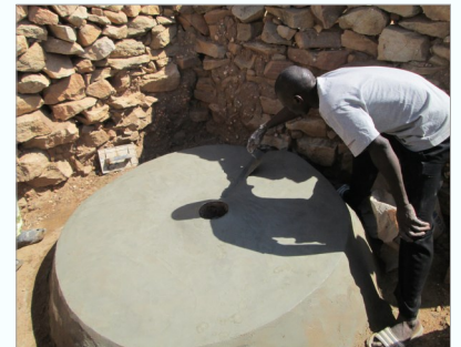
9. Latrine traditionnelle finalisée dans la zone sableuse argileuse.
