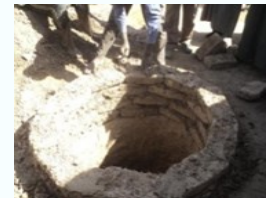
Construction du trou de latrines en zone inondée
