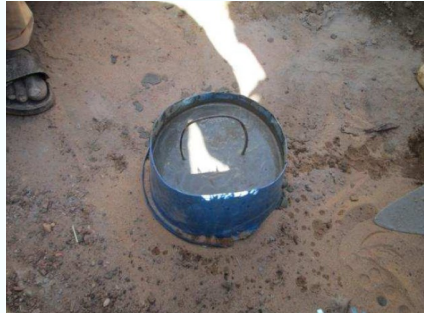
8. Le couvercle du trou est modelé avec du ciment et du sable dans une moule confectionnée manuellement.
