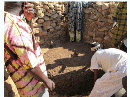
6. Le tout est couvert de mélange de banco, de la bouse de vache et de l'huile de vidange pour empêcher l'infiltration de l'eau par le toit
