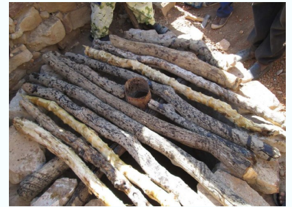
3. Les bois utilisés sont enduits d'huile de vidange pour résister à l'attaque des termites.
