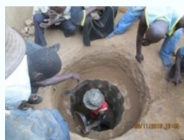
Stabiliser de paroi en zone sablonneuse
