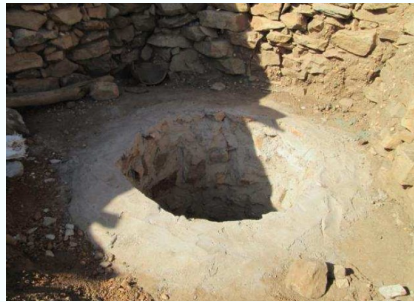
2. Le trou est stabilisé avec des pierres taillées par les maçons locaux.
